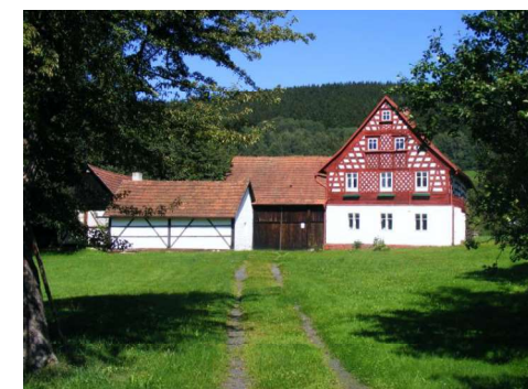
obr. č. C. 212: Renovovaný uzavřený čtyřstranný menší dvorec chebského typu, dnes užívaný jako muzeum; dům s hrázděným patrem na roubeném věnci, s hrázděným štítem pod sedlovou střechou; dřevěná široká brána navazuje na sýpku, dvůr uzavírají kůlna a stodola
