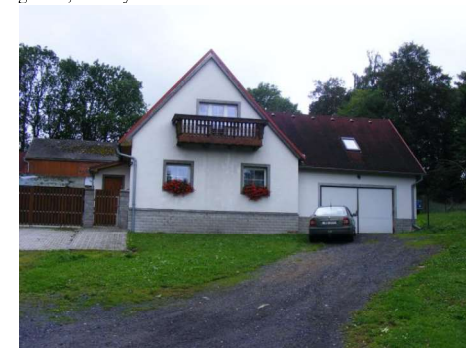
obr. č. C. 25: Nevhodná renovace toho samého objektu: přerušená korunní římsa a jiný počet a umístění oken ve štítě
