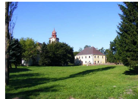
obr. č. C. 243: Jednoduchá hladká hmota patrové bývalé fary s vysokou valbovou střechou; ve značně neutěšeném stavu dnes slouží k bydlení
