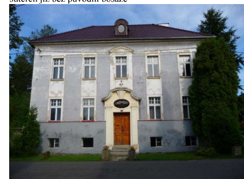
obr. č. C. 349: Dobře zachovalá empírová fara s vchodem v ose uliční podélné fasády zdůrazněným zdobným portálem; suterén již bez původní bosáže
