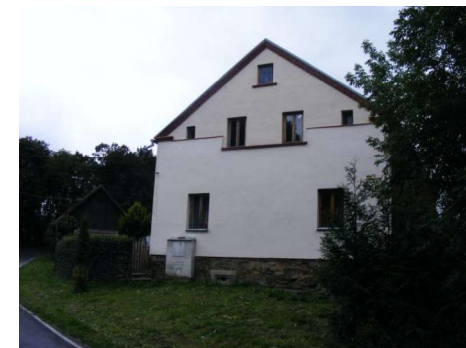
obr. č. C. 25: Nevhodná renovace toho samého objektu: přerušená korunní římsa a jiný počet a umístění oken ve štítě
