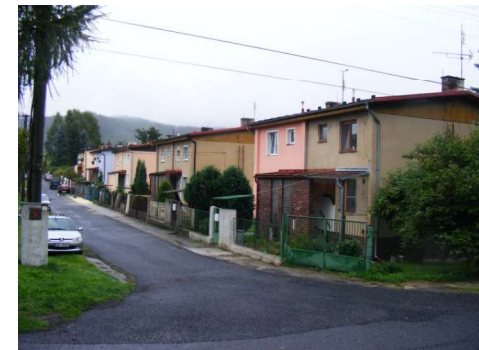
obr. č. C. 330: Městský charakter skupiny novodobých patrových dvojdomků se spojenými závětrými opticky zvýrazněnými kabřincovým obkladem
