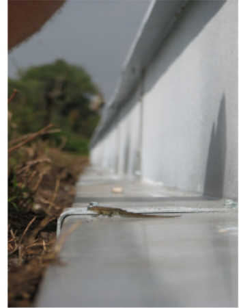
Obr. 37,38,39: Ocelové zábrany byly v Nizozemí použity jako dočasné opatření v průběhu stavbě. Vzhledem ke své výšce 50 cm, tvarovanému okraji a poměrně odolnému materiálu, který vydrží i management jsou vhodným řešením (Struijk 2010).
