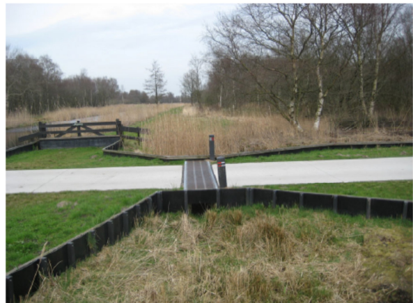
Obr. 43, 44: Drsnější povrch kotvicích sloupků může usnadnit překonání zábrany, proto by tyto měly být umístěny z opačné strany, než jak je provedeno na této lokalitě (Struijk 2010)
