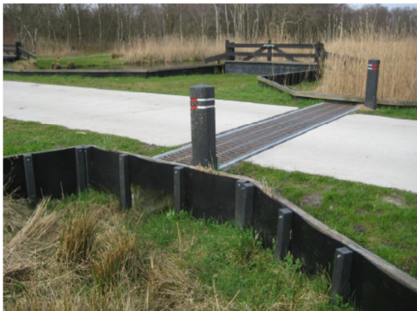
Obr. 43, 44: Drsnější povrch kotvicích sloupků může usnadnit překonání zábrany, proto by tyto měly být umístěny z opačné strany, než jak je provedeno na této lokalitě (Struijk 2010)
