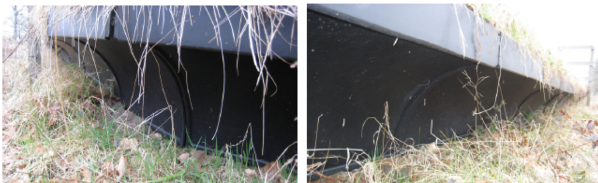
Obr. 33,34: Řada druhů plazů je schopna překonávat zábrany, tvarováním zábrany lze učinit překonání obtížnějším (Struijk 2010)
