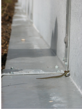
Obr. 37,38,39: Ocelové zábrany byly v Nizozemí použity jako dočasné opatření v průběhu stavbě. Vzhledem ke své výšce 50 cm, tvarovanému okraji a poměrně odolnému materiálu, který vydrží i management jsou vhodným řešením (Struijk 2010).
