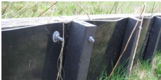
Obr. 40,41,42: Zábrany plastové a z PVC či polyetylenu nejsou dostatečně odolné teplotní výkyvům. Zábrany na obrázku jsou určené pro ještěrku živorodou, užovku obojkovou a hladkou a zmiji obecnou (Struijk 2010)
