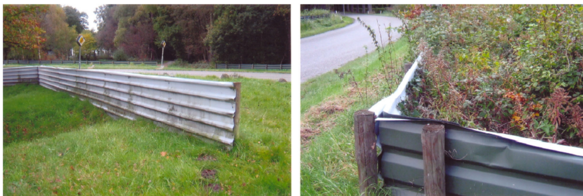
Obr. 35,36: Kovové zábrany pro užovku obojkovou, přerůstající vegetace však usnadnit může průnik druhu (Struijk 2010)
