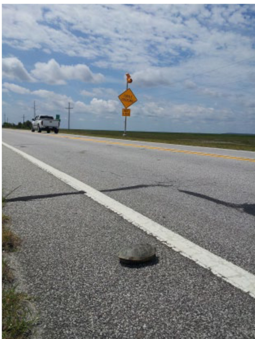
Obr. 47: Značka upozorňující na častý výskyt želvy diamantové na silnici s blikáčem, který se spouští v dopravních špičkách (Andrews a kol. 2015).
