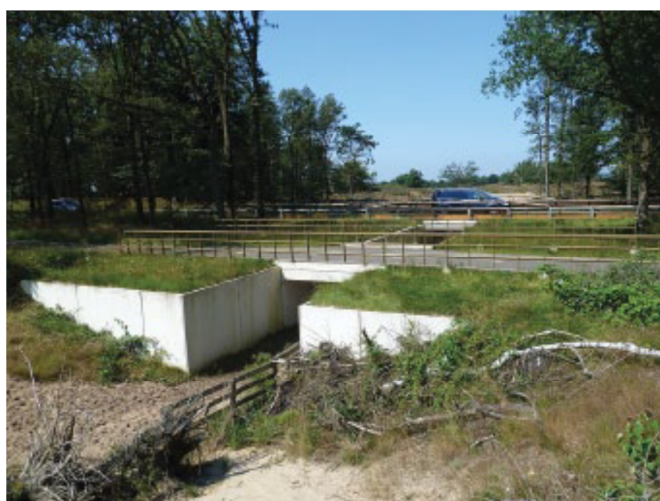
Obr. 28: Herpetodukt Elspeesche Heide - částečně otevřený podchod pod komunikací s prokázaným využíváním několika druhů plazů, viz dále, (Struijk a kol. 2014)
