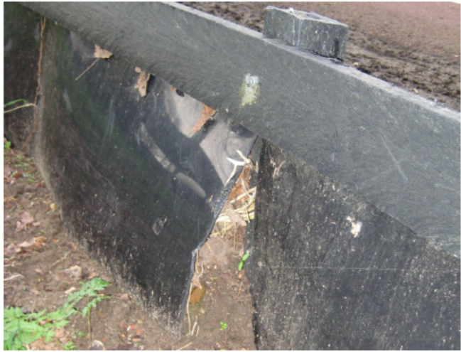
Obr. 40,41,42: Zábrany plastové a z PVC či polyetylenu nejsou dostatečně odolné teplotní výkyvům. Zábrany na obrázku jsou určené pro ještěrku živorodou, užovku obojkovou a hladkou a zmiji obecnou (Struijk 2010)
