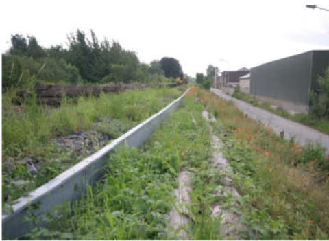
Obr. 37,38,39: Ocelové zábrany byly v Nizozemí použity jako dočasné opatření v průběhu stavbě. Vzhledem ke své výšce 50 cm, tvarovanému okraji a poměrně odolnému materiálu, který vydrží i management jsou vhodným řešením (Struijk 2010).
