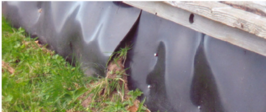
Obr. 37,38,39: Ocelové zábrany byly v Nizozemí použity jako dočasné opatření v průběhu stavbě. Vzhledem ke své výšce 50 cm, tvarovanému okraji a poměrně odolnému materiálu, který vydrží i management jsou vhodným řešením (Struijk 2010).
