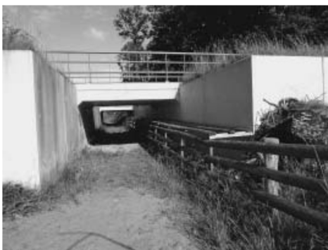
Obr. 64 - 68: Herpetodukt v Nizozemí s mnoha speciálními prvky pro plazy je funkční a jeví se jako optimální řešení (Struijk a kol. 2014)
